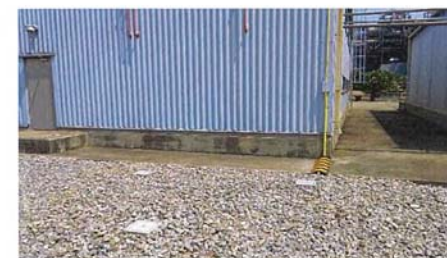
Block 1 อาคารเก็บก๊าซ H2 หลังทำการติดตั้ง Ground Test Box สายล่อฟ้า.
